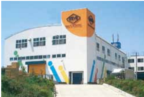
本社工場(大阪・堺市)
