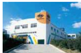
本社工場(大阪・堺市)
